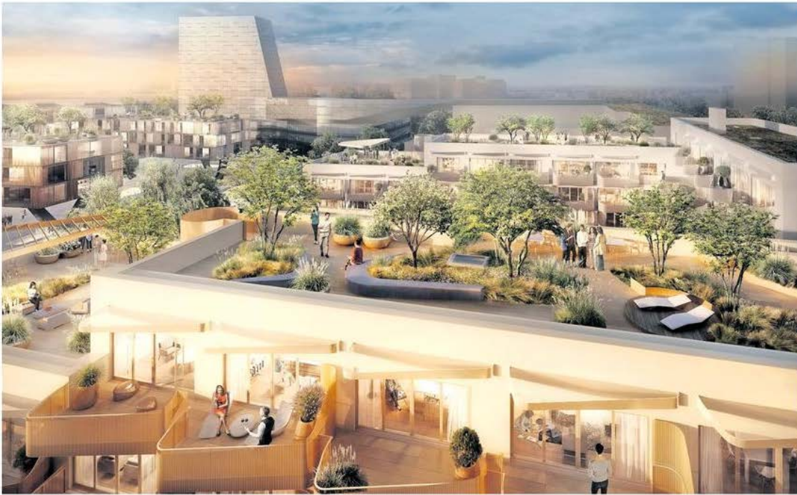
Attraktive Logenplätze: So soll der erste Gebäudekomplex (im Vordergrund) des Kulturquadrats nach der Fertigstellung aussehen. Ein Highlight verspricht auch dessen Dachgarten zu werden, der den Bewohnern einen Ausblick auf das künftige Kulturbürgerhaus Neuperlachs erlaubt. SIMULATION: BHB BAUTRÄGER GMBH BAYERN
